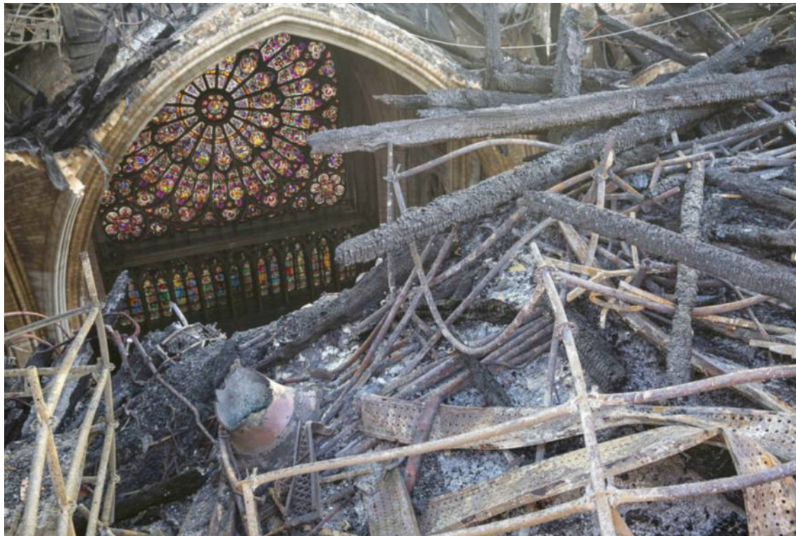
Le 25 juin 2019, à l'emplacement de la flèche. Les restes de l'échafaudage seront démontés pièce par pièce (photo parue dans La Croix du 15 avril). Patrick Zachmann/Magnum Photos
